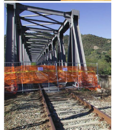
Sotto, il ponte della ferrovia, fino a qualche anno fa in uso alla linea Santhù-Arona, che collega Gattinara a Romagnano. Sarà utilizzato come viadotto provvisorio per le auto (foto Sandro Mori)
