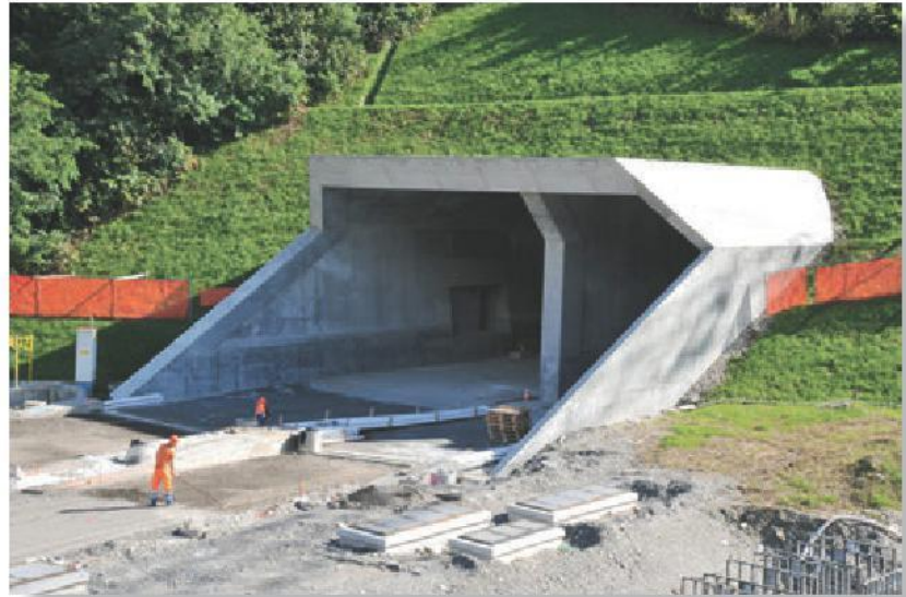
Lavori alla galleria del Ceneri in Svizzera
