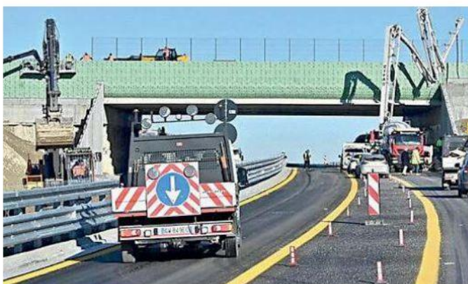
Un cantiere lungo l'Asti-Cuneo
