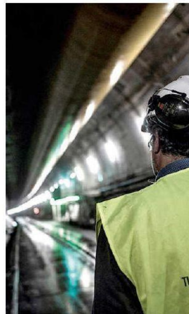
Il cantiere della Torino-Lione
