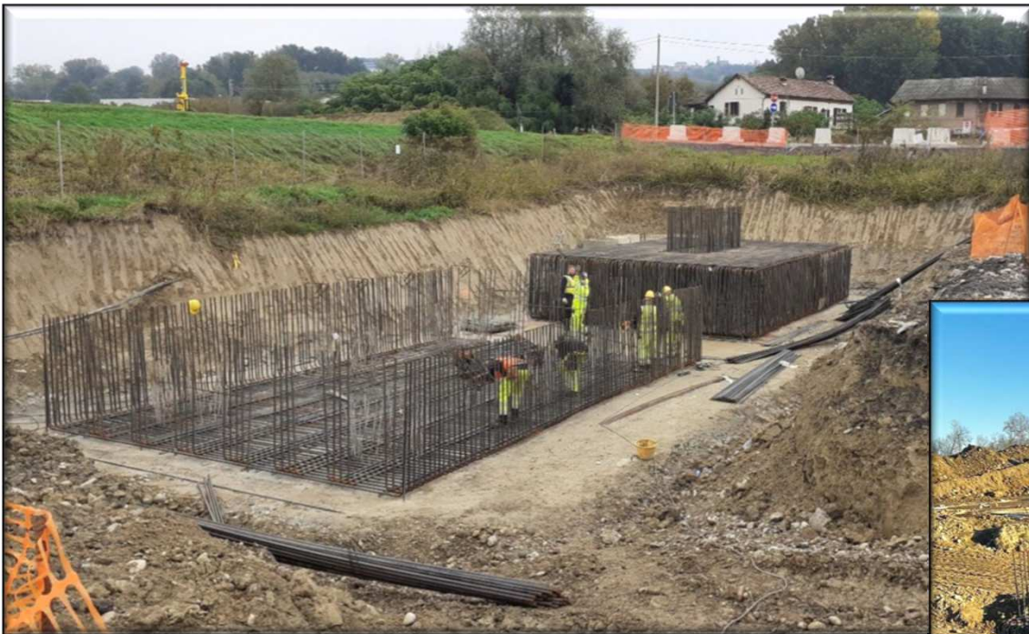
Armatura plinto fondazioni pile viadotto SP 7
