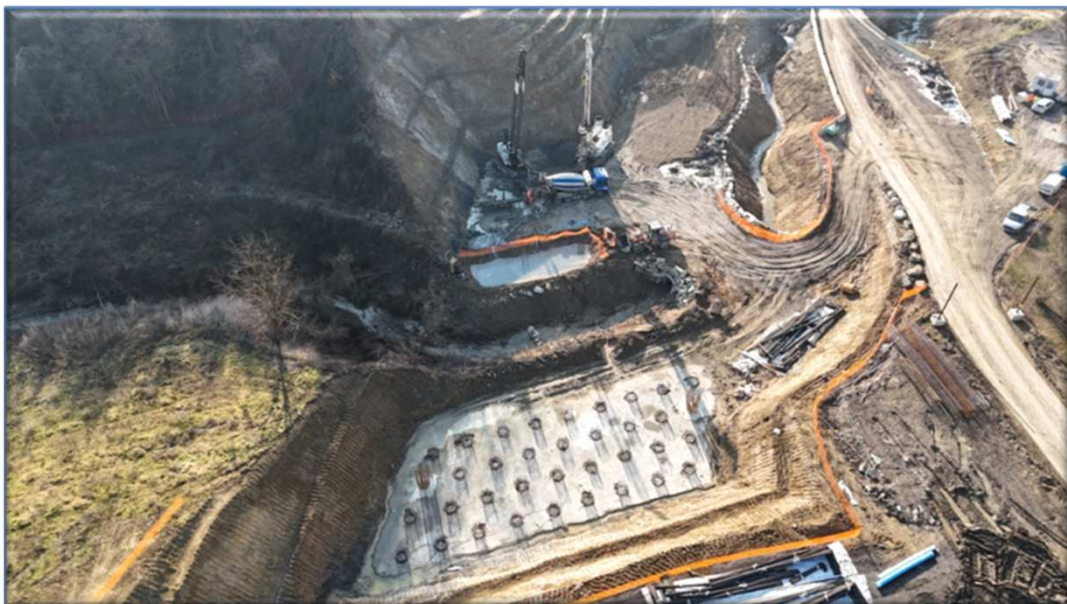
Fondazioni speciali spalla ponte Rio Deglia
