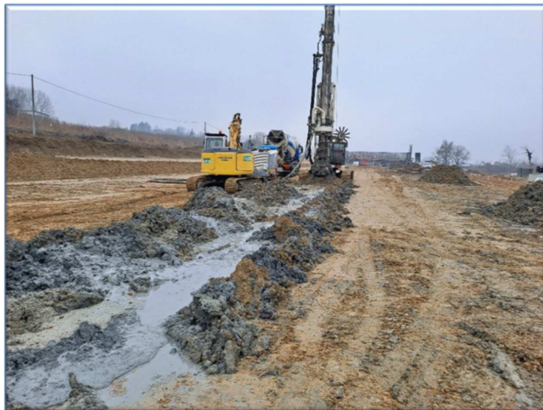
Getto pali CFA Consolidamento piano di posa dei rilevati
