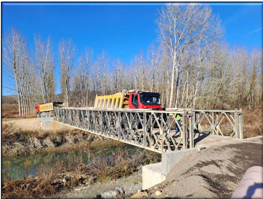
Ponte Bailey piste di cantiere
