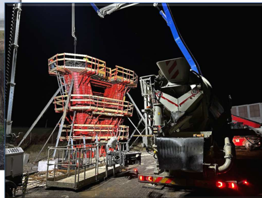
Viadotto SP 7 Pile
