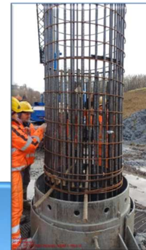
Esecuzione pali di fondazione di grande diametro
