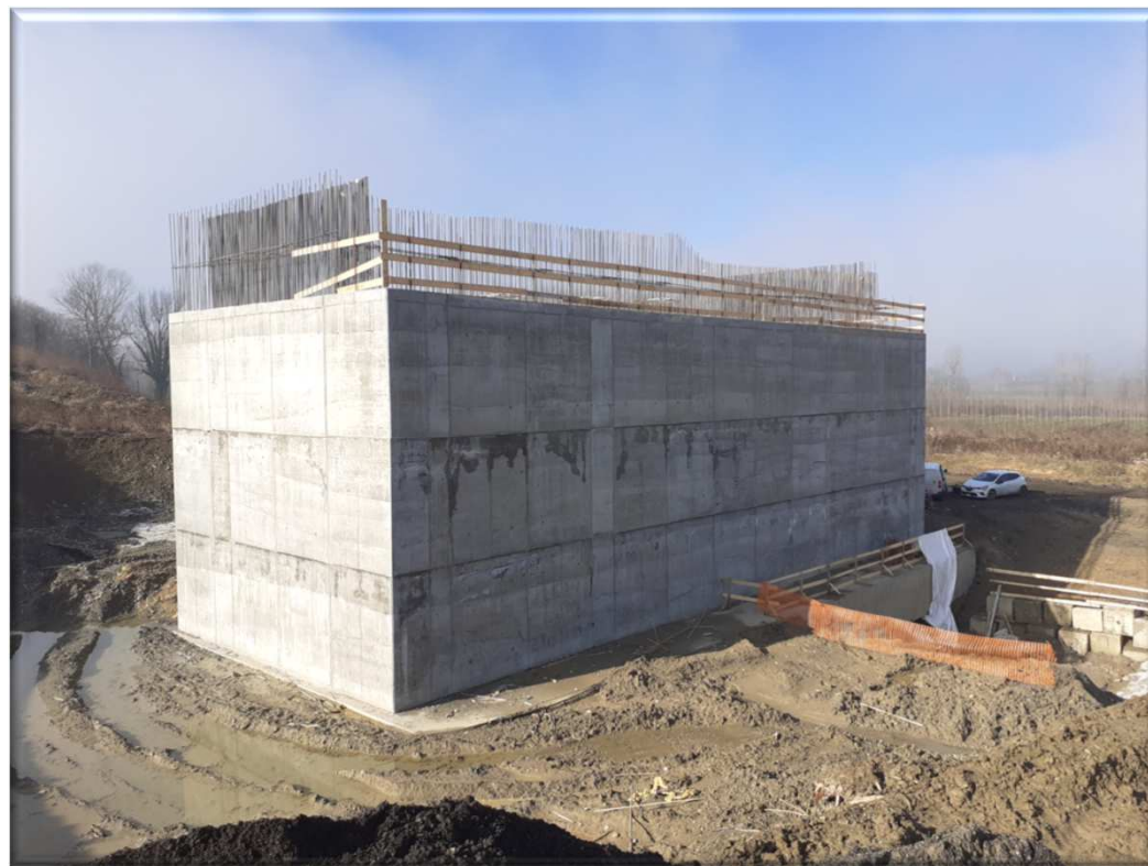
Viadotto SP 7 Spalla
