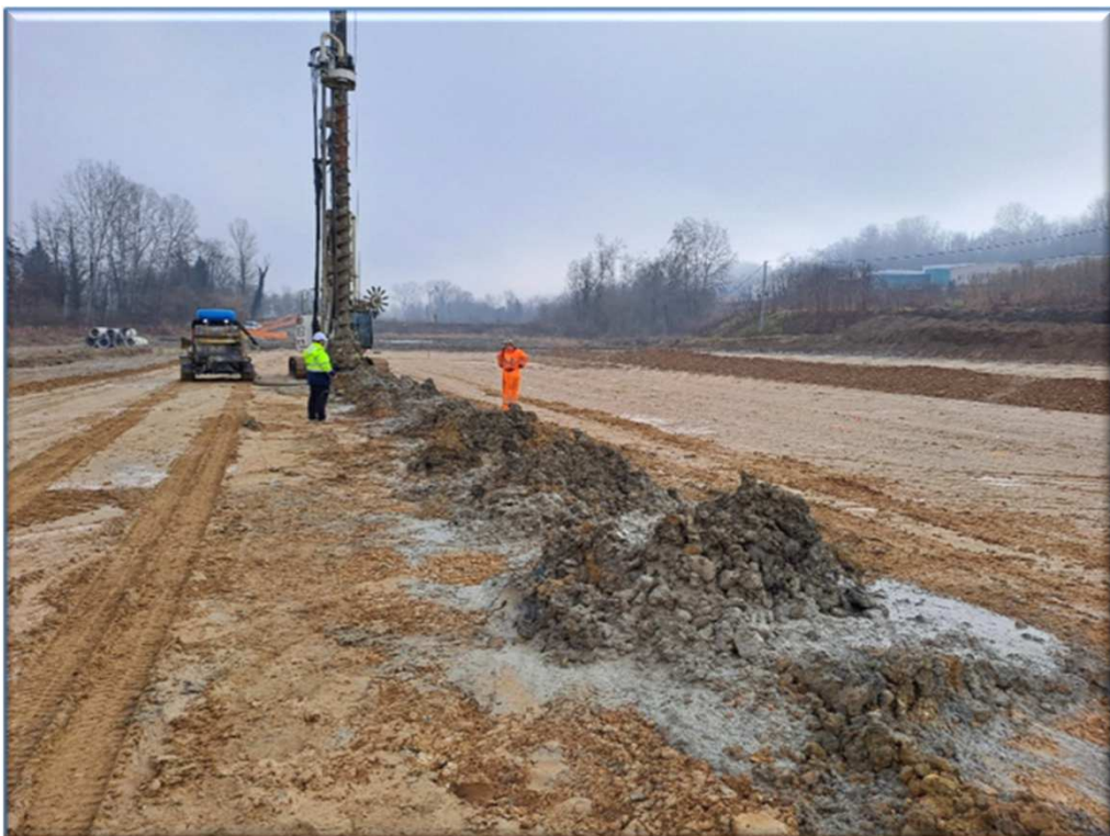
Trivellazione pali CFA Consolidamento piano di posa dei rilevati
