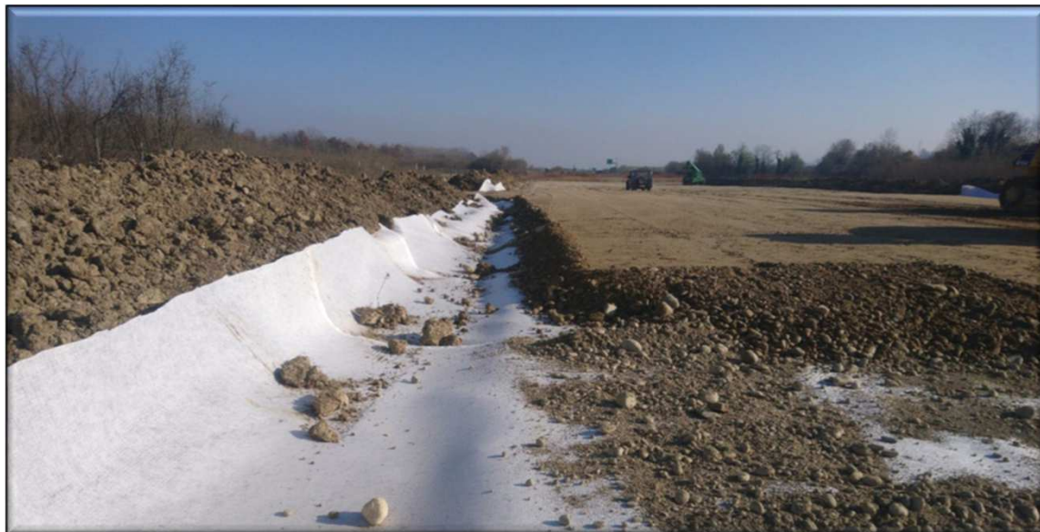
Stesa geocomposito anticapillare sul piano di posa dei rilevati
