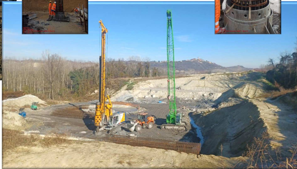
Esecuzione pali di fondazione di grande diametro
