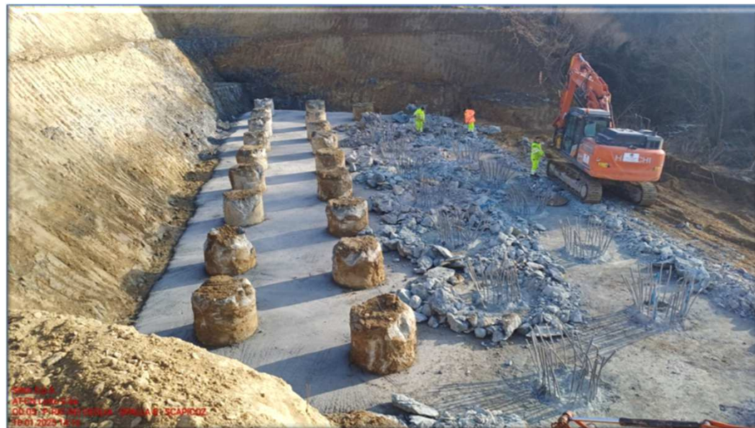
Scapitozzatura teste dei pali di fondazione spalla ponte Rio Deglia
