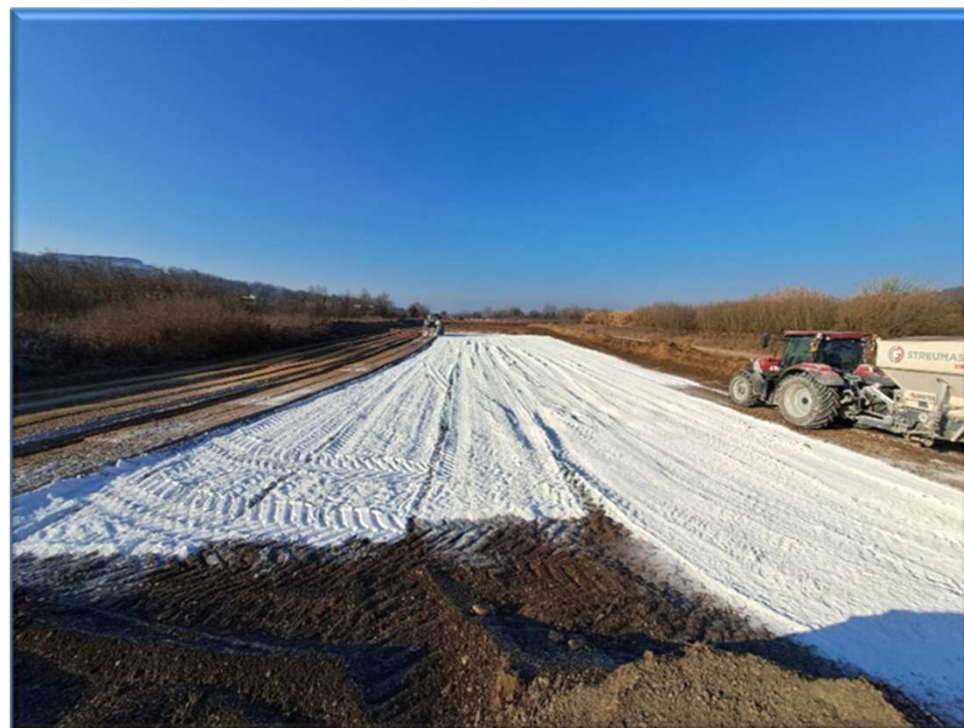
Stabilizzazione a calce piano posa rilevati
