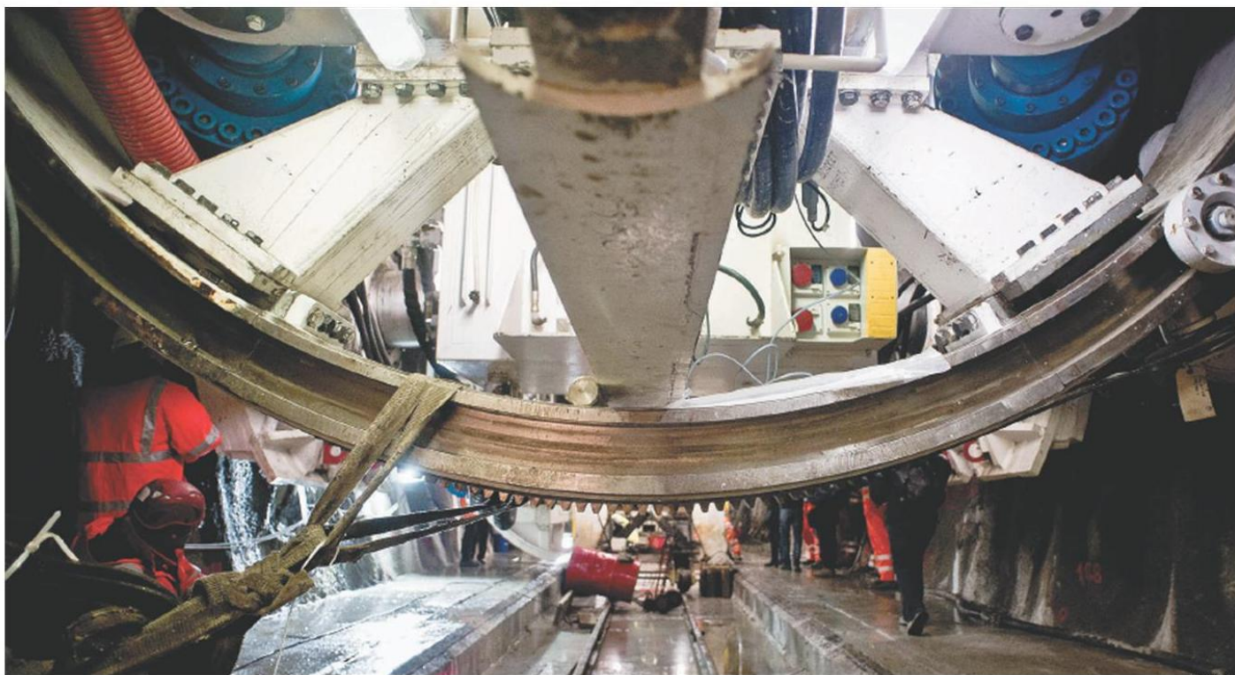
Il tunnel della Torino-Lione al cantiere di Chiomonte: sono in corso le valutazioni per il mega-appalto da 2,3 miliardi
